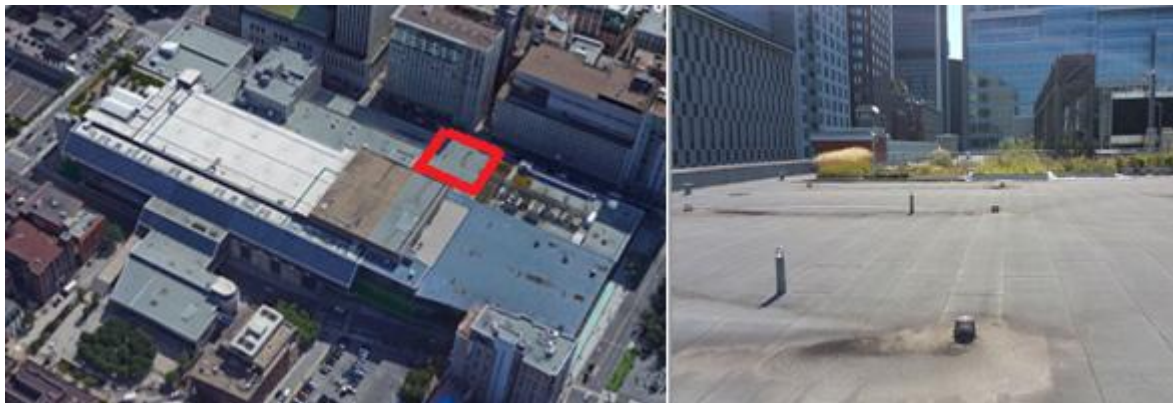
Figure 1. Emplacement de la zone d'accueil du projet VERTICAL sur le toit du Palais des congrès. A) photo aérienne, b) photo sur le toit avant installation.
