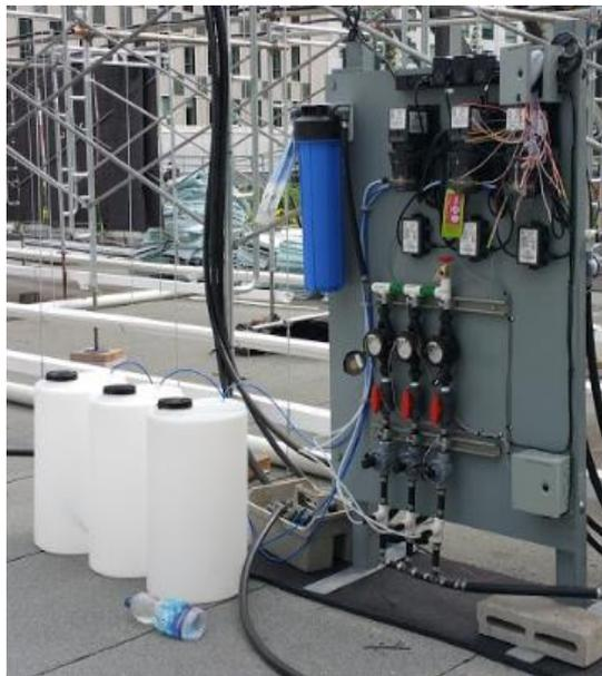
Figure 17 : Panneau de contrôle du système d'irrigation – fertilisation
